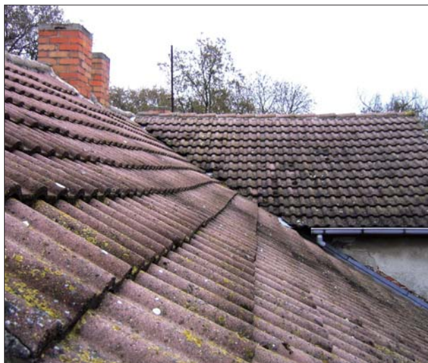
Příklad rekonstrukce staré střechy: stará krytina z betonových tašek
